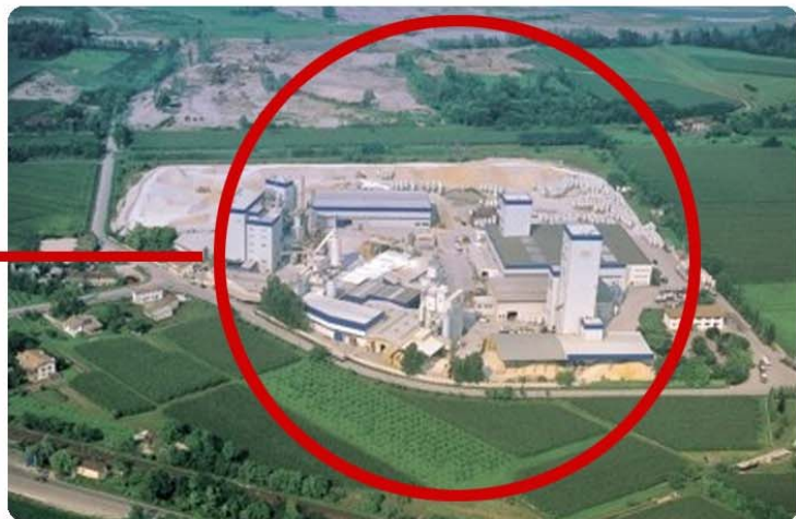
Uno degli stabilimenti Fassa Bortolo
